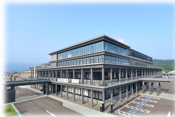
大野市庁舎整備工事
