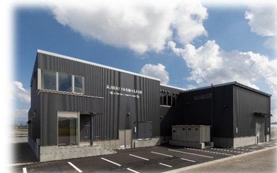
株式会社アジチファーム 食品加工工場新設工事
